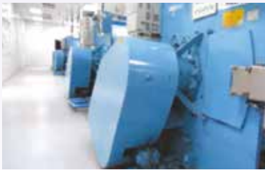
Lavage à l'eau désionisée Salle blanche ISO 5
